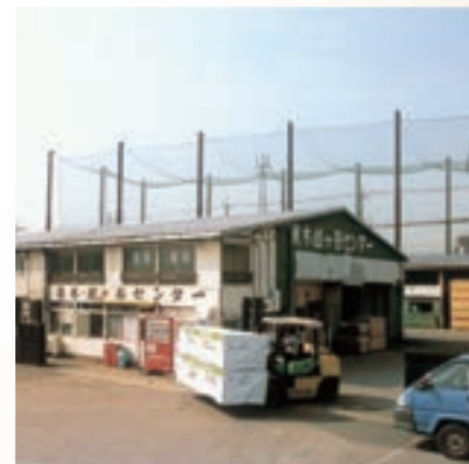
越谷センター外観
